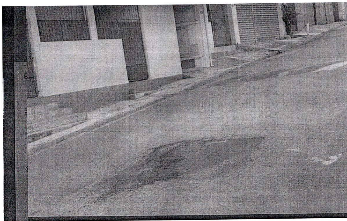
RUA COROADOS ALTURA Nº 155 - PARQUE PARAISO
