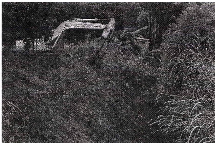
Limpeza na calha do Ribeirão dos Cristais
